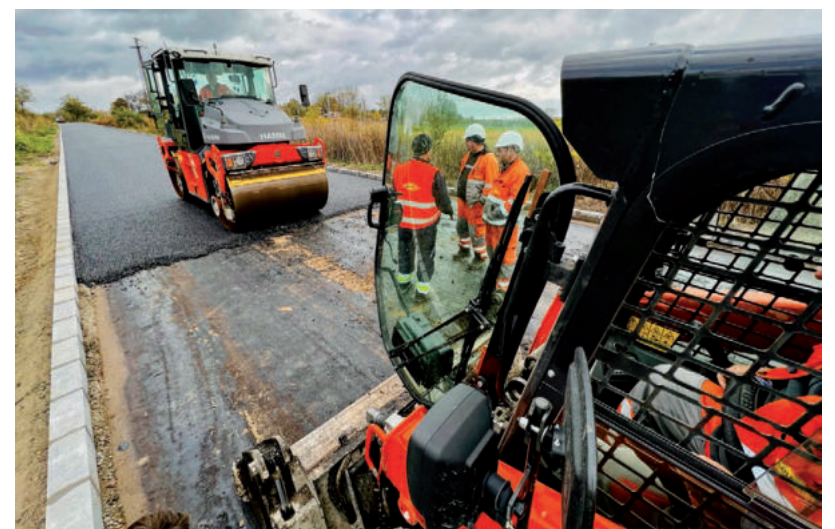
LÁTVÁNYOS SZAKASZÁHOZ ÉRKEZETT A TÓTH MALOM UTCA ÉPÍTÉSE
