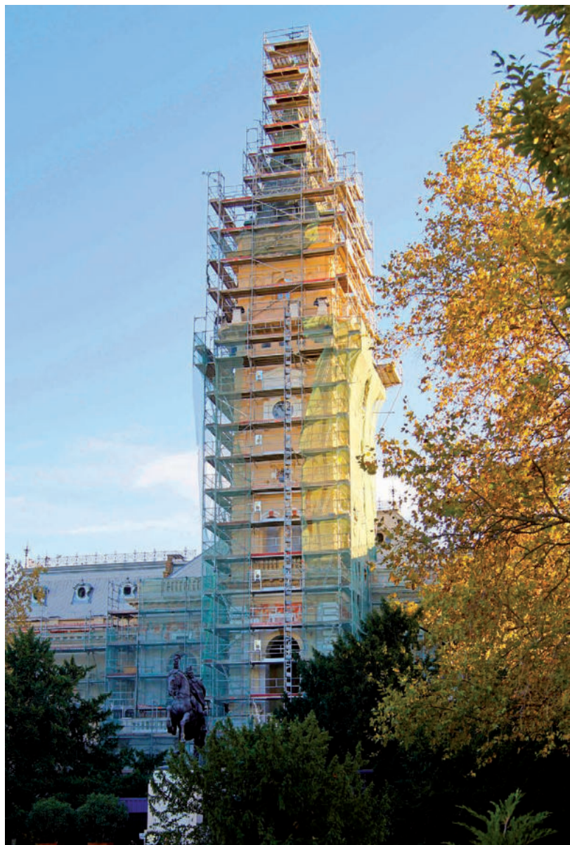
AZ ÁLLVÁNYZATON KERESZTŰL MÁR LÁTSZIK AZ ÚJ VAKOLAT, A SZÍN MÉG NEM VÉGLEGES
