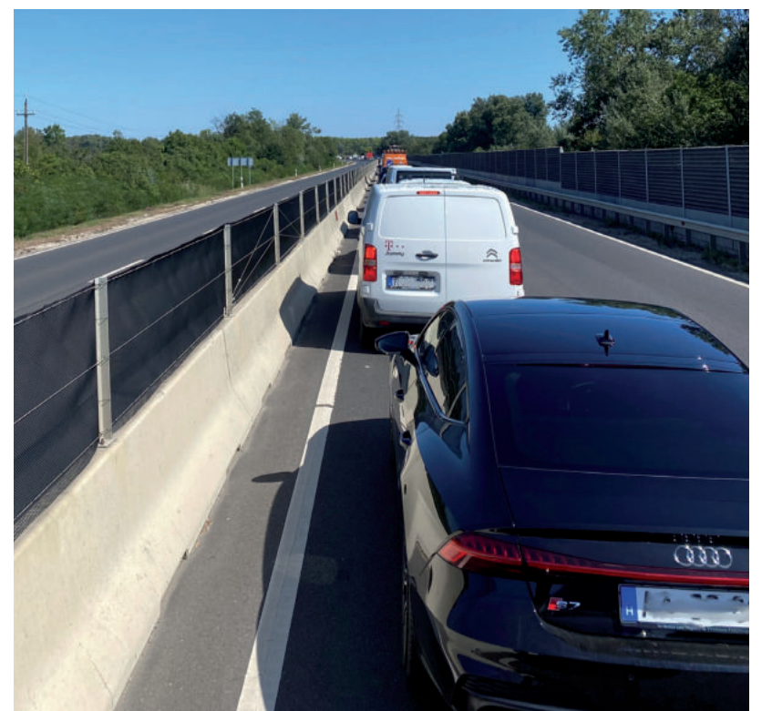
A HÍD GYAKORI JAVÍTÁSA, FÉLPÁLYÁS LEZÁRÁSA MIATT HOSSZÚ VÁRAKOZÁSRA KÉNYSZERÜLNEK A KÖZLEKEDŐK
