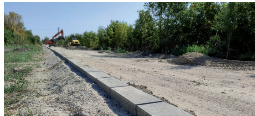
MÁR A SZEGÉLYKÖVEKET RAKJÁK LE AZ ÉPÜLŐ ÚT MENTÉN
