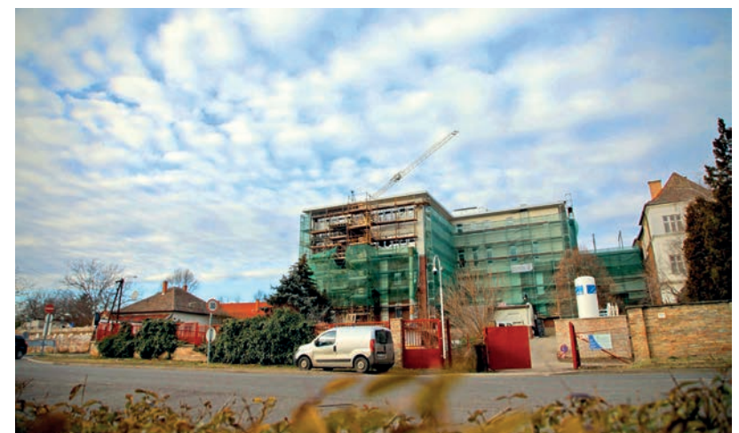
TÖBB ÉPÍTÉSI SZAKEMBER ESETT KI A MUNKÁBÓL KORONAVÍRUS-FERTŐZÉS MIATT.
