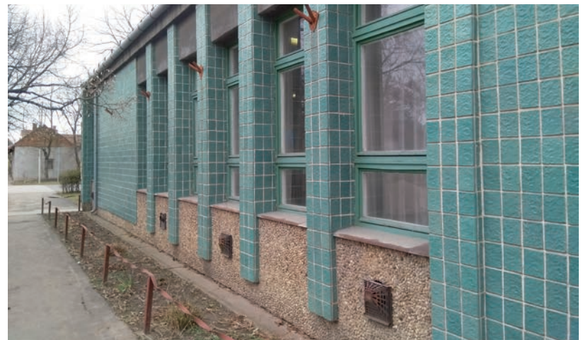
A CSÚCSI OLVASÓKÖR ÉPÜLETÉNÉL KICSERÉLIK A NYÍLÁSZÁRÓKAT
