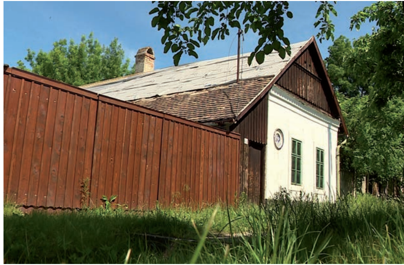
A TETŐ IS MEGÚJUL A FAZEKASHÁZON
