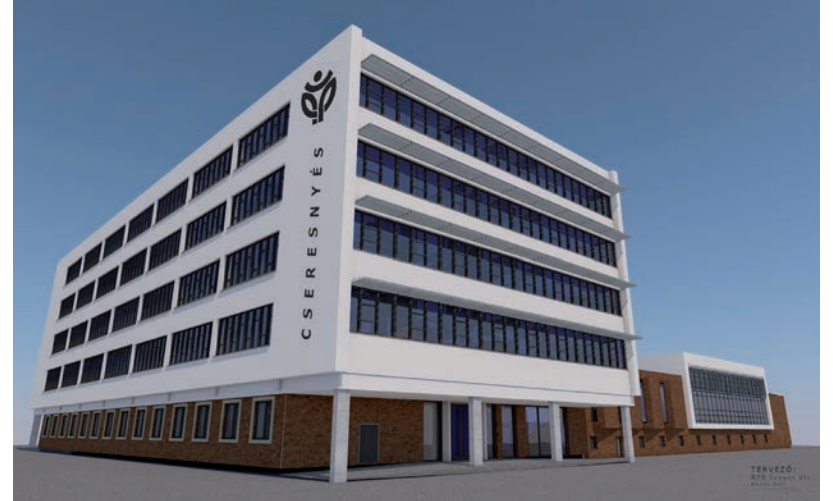
AZ 1966-BAN ÉPÜLT CSERESNYÉS KOLLÉGIUM VÉGRE MÉLTÓ KÖNTÖSBÉ ÖLTÖZIK, HOMLOKZATA FELFRISÜL
